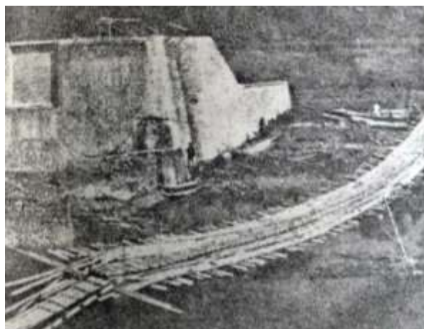
Gambar 1. Pengerjaan kontruksi bendungan Watervang tahun 1939-1941 Sumber: Kitlv.nl
