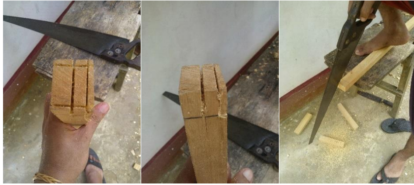
Gambar 5. Proses pembuatan sambungan kayu
