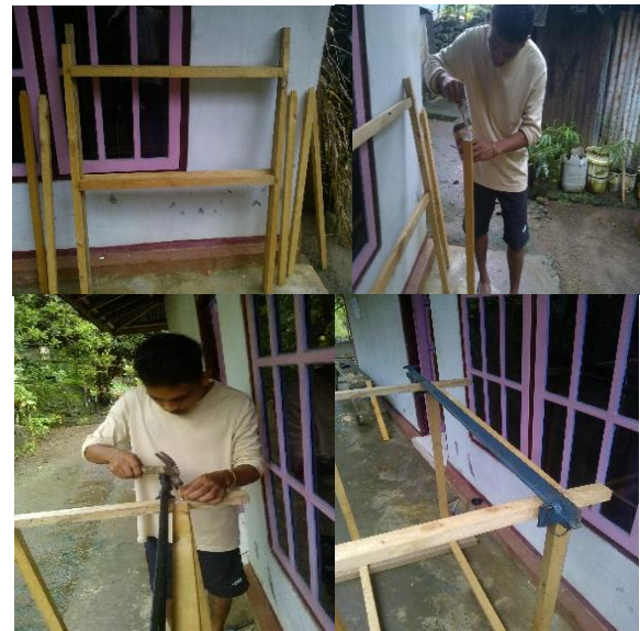
Gambar 7. Proses pemasangan rangka
