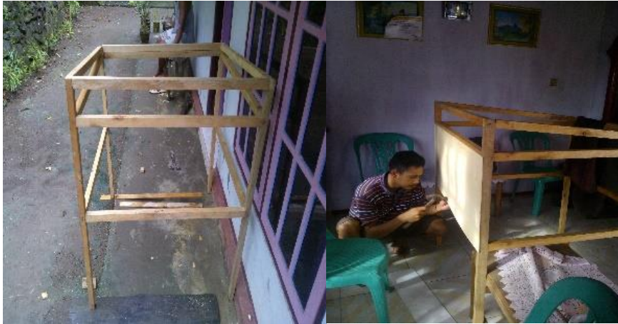
Gambar 8. Proses pemasangan penutup belakang Solar dryer
