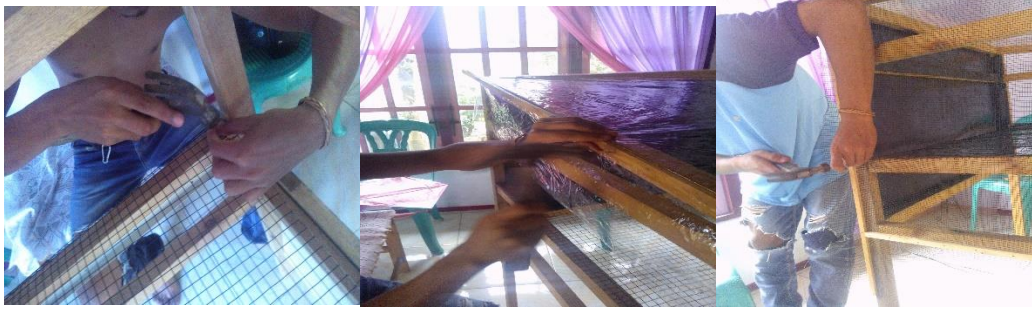
Gambar 10. Proses pemasangan penutup, rak dan net
