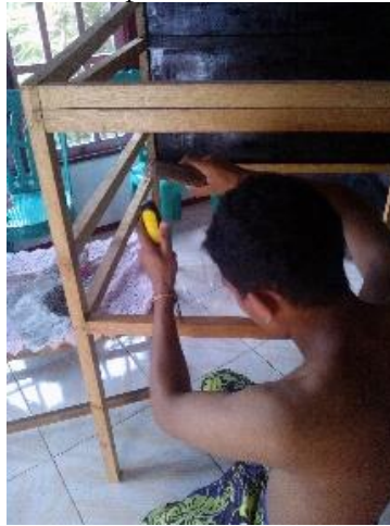
Gambar 9. Proses pemasangan pintu.
