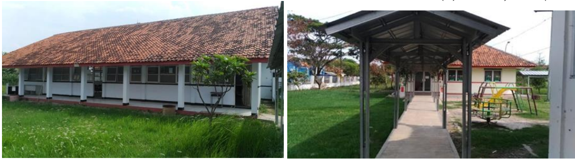
Gambar 2 & 3 Gedung sekolah SKB Kabupaten Karawang
