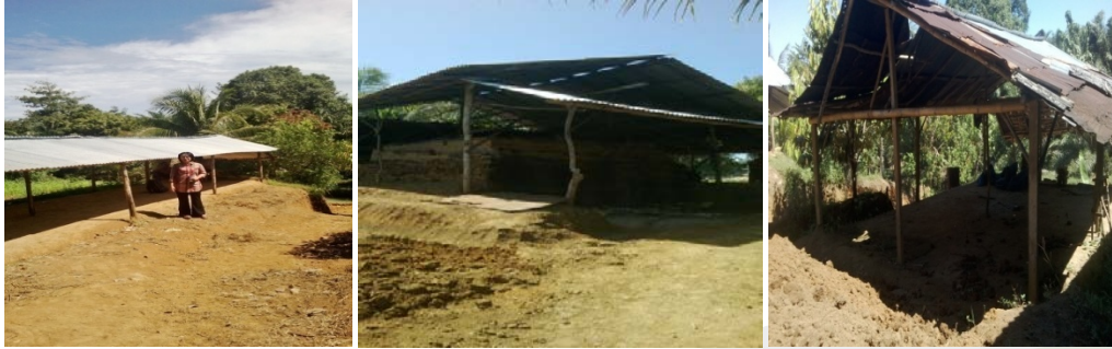
Gambar 3.2. Bangunan tempat pencetakan dan pengumpulan Batu Bata
