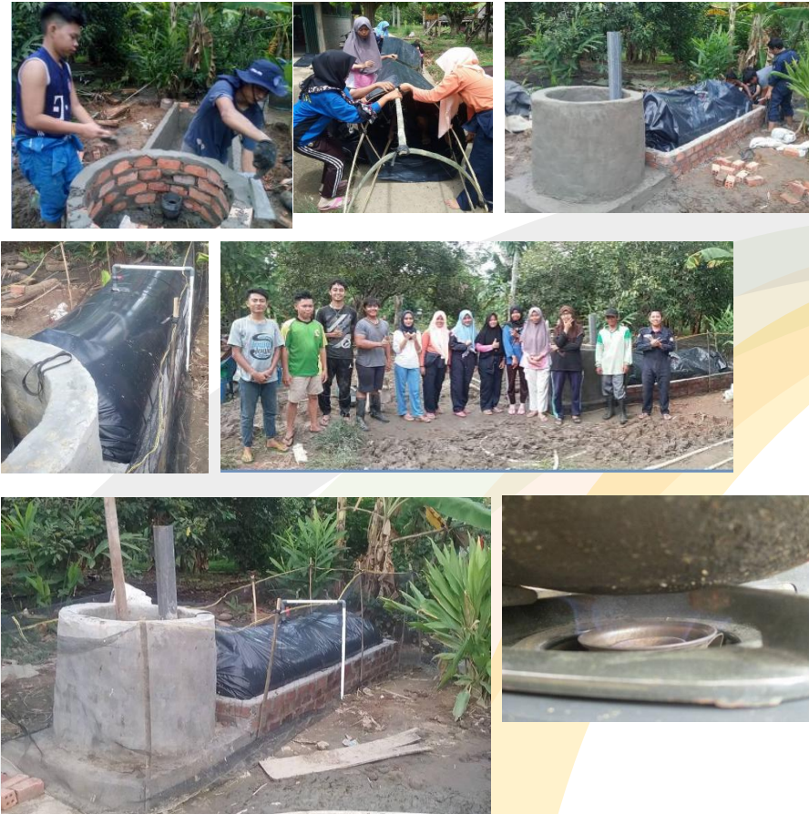
Gambar 2 Proses Pembuatan Digester Biogas dan api biru dari digester
