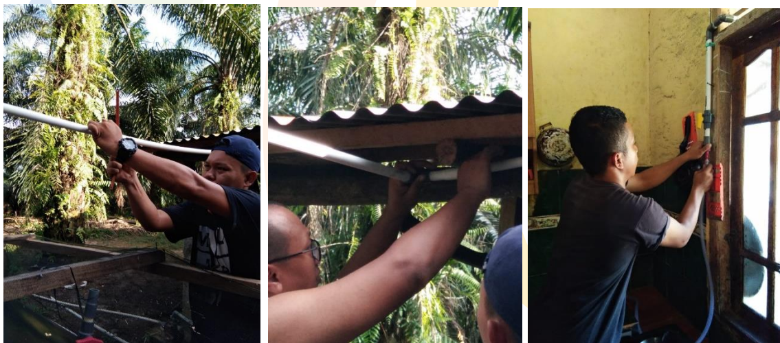
Gambar 2. Pemasangan digester dan instalasi pipa penyalur gas menuju rumah tangga
