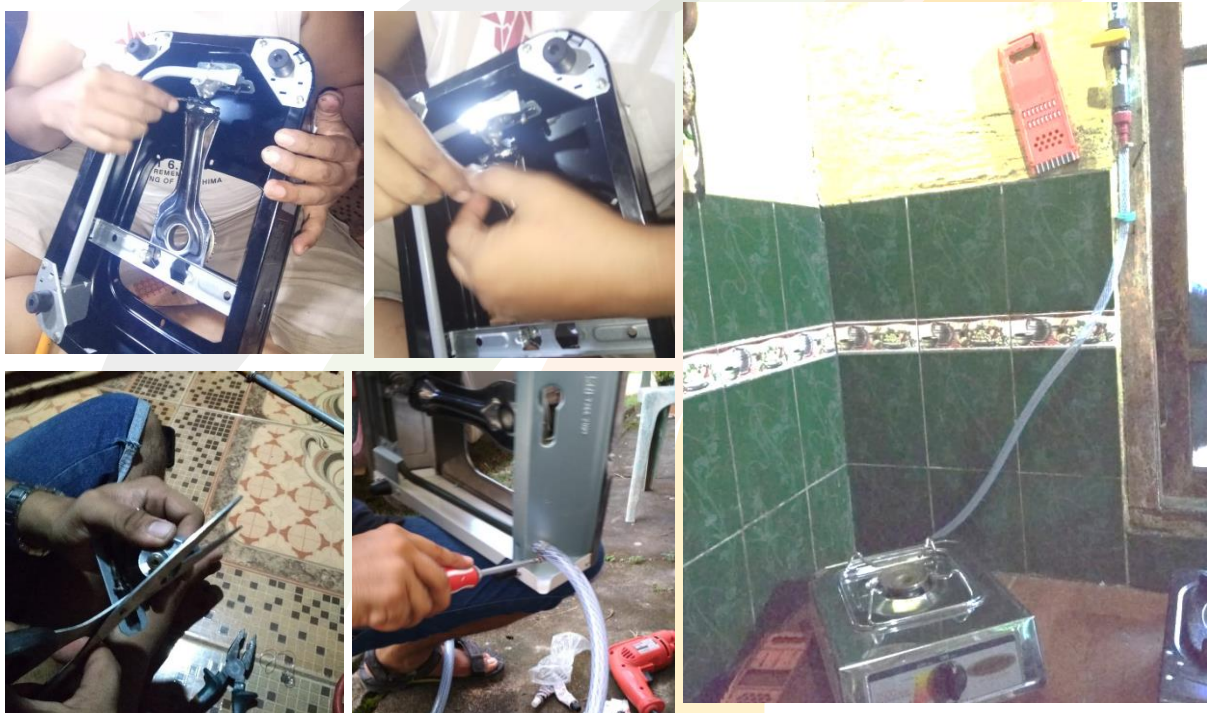
Gambar 3. Penyetelan, pemasangan kompor gas yang terhubung instalasi pipa gas.
