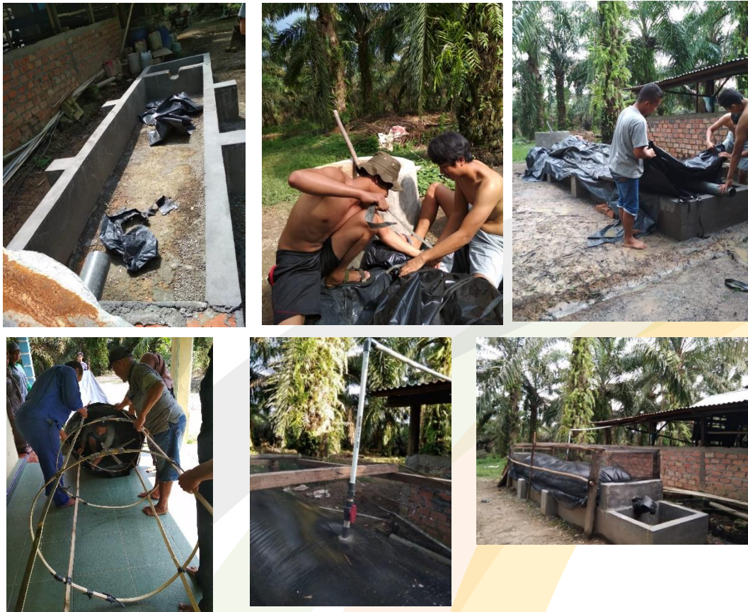
Gambar 1. Foto-foto kegiatan pembuatan digester biogas dilokasi
